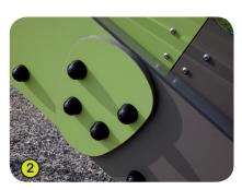
**2- Les flancs** sont constitués de plaques colorées élaborées à partir d'un matériau compact (HPL), d'une épaisseur de 13 mm. Matériau robuste, il présente une excellente résistance aux intempéries et au vandalisme.
