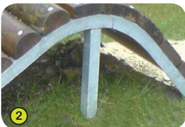
2- **Les châssis** sont en acier galvanisé.
