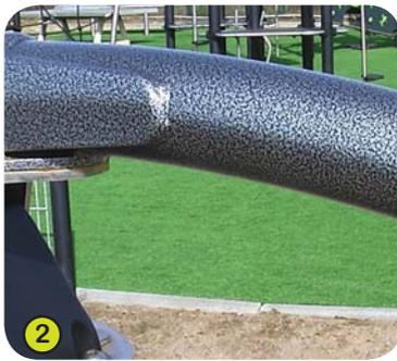
2- **Die Gestänge** mit 60 mm Durchmesser sind aus lackiertem Stahl.
