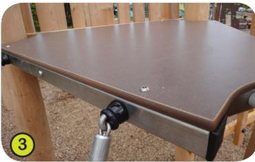
3- **Die Standflächen der Plattformen** sind aus 12,5 mm starken, an der Oberfläche rutschfest strukturierten, Harzkompositplatten (HPL), die auf stabilen Unterzügen aus verzinktem Stahl befestigt werden.
