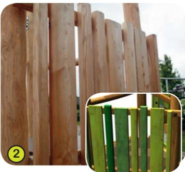
2- **Brüstungen, Kletterwände, Tunnel und Holzbalken mit den Maßen 140 x 27 mm / 45 x 68 mm** sind aus witterungsbeständiger Lärche. Die Brüstungen können auf Wunsch grün lasiert geliefert werden.
